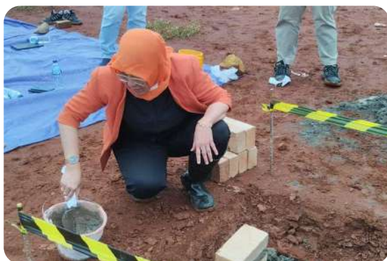
Peletakan Batu Pertama Pabrik Batang 2023 Groundbreaking for Batang Plant 2023
