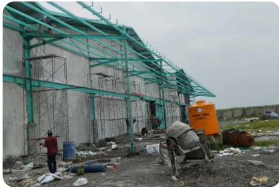
Pembangunan Gedung Mojoagung 6 - 9 dimulai Commencing Building 6 - 9 Construction in Mojoagung
