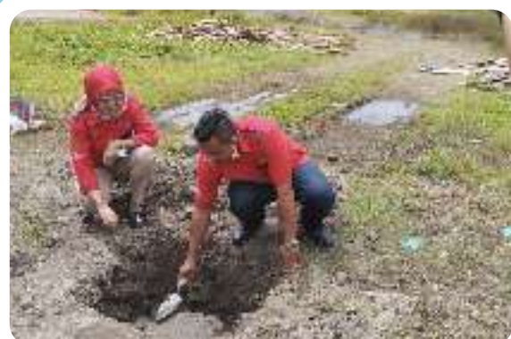
Peletakan Batu Pertama Mojoagung II Gedung 10-17 Groundbreaking of Mojoagung II Building 10-17
